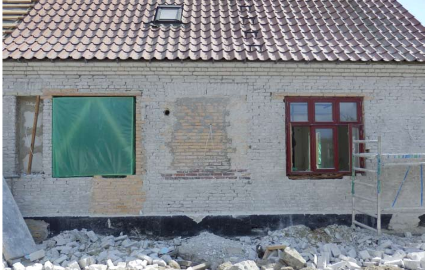
Tilsynsbillede af nordvestfacade taget d. 5.5.2014
