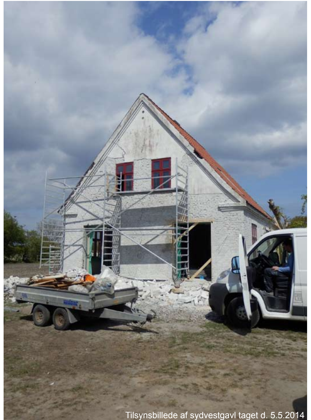
Tilsynsbillede af tilbygning taget d. 5.5.2014
