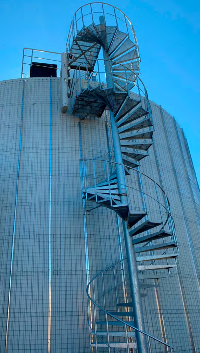
Kølelager på energicentralen på Tårnby renselanlæg.
