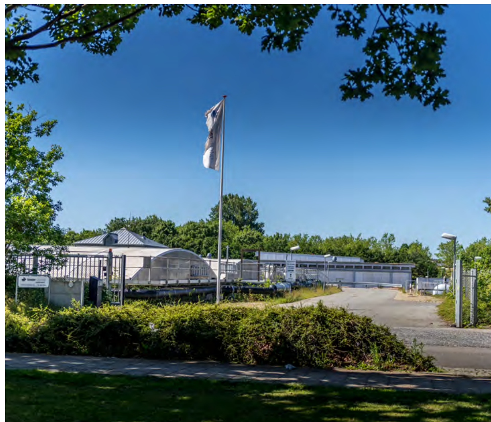
Tårnby Renseanlæg ved indgangen.
