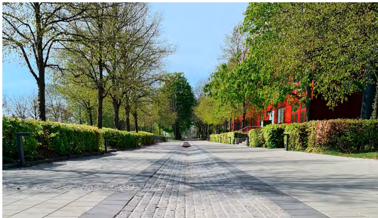
Vandrede til lokal afledning af overfladevand ved Amagerhallen.
