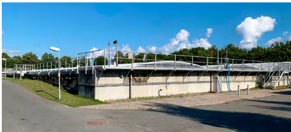
Overdækkede bioreaktorer på Tårnby Renseanlæg.
