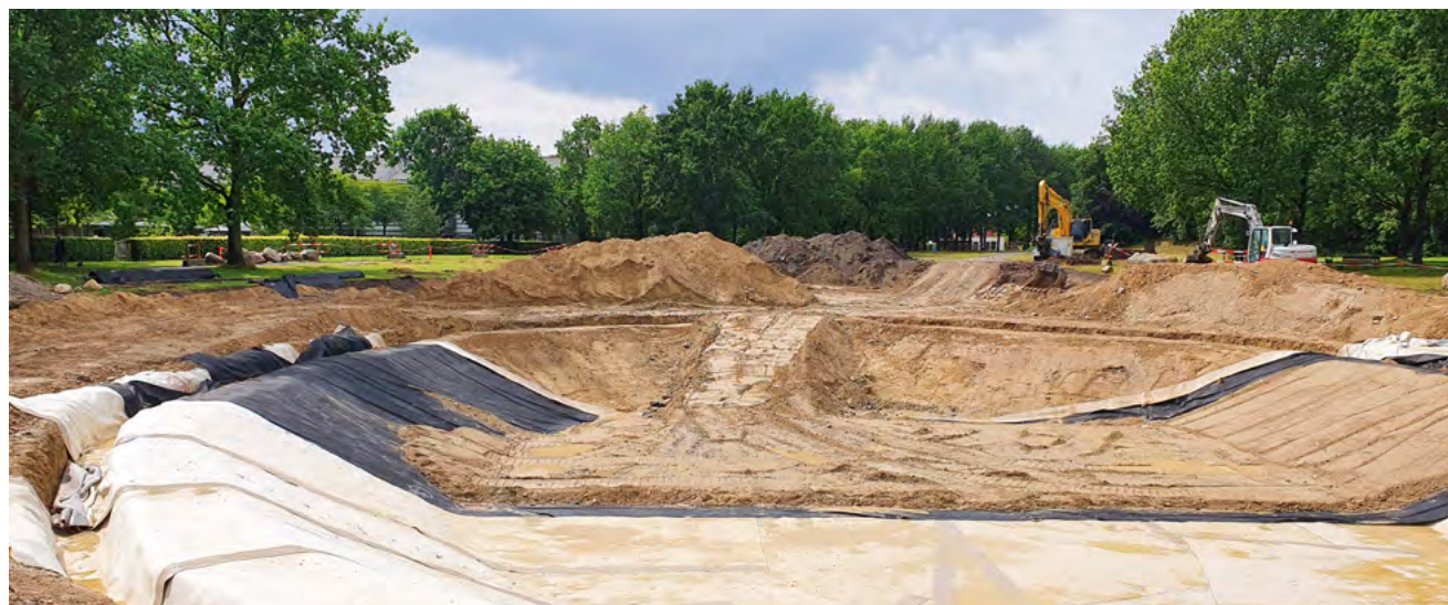
Udgravning af forsinkelsesbassin i Travbaneparken.
