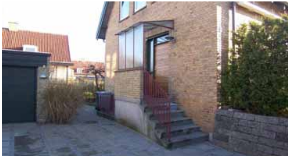
Vindfang og halvtag opføres i glas og med lodret metalsprosnings for at tilstræbe det oprindelige æstetiske udtryk
