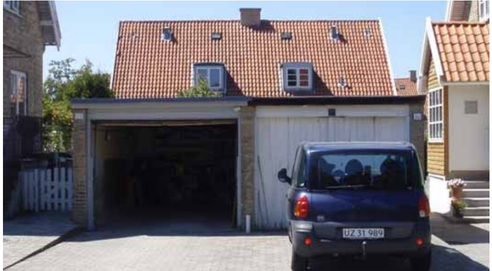
De eksisterende garager skal bevares med sit oprindelige udtryk i blank gul mur
